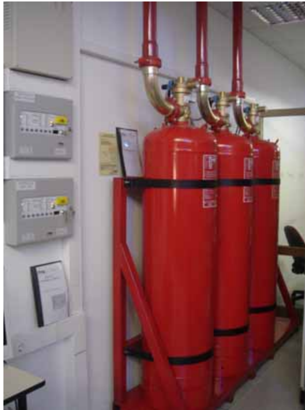
Dio novog sustava vatrozaštite računalne hale Srca
